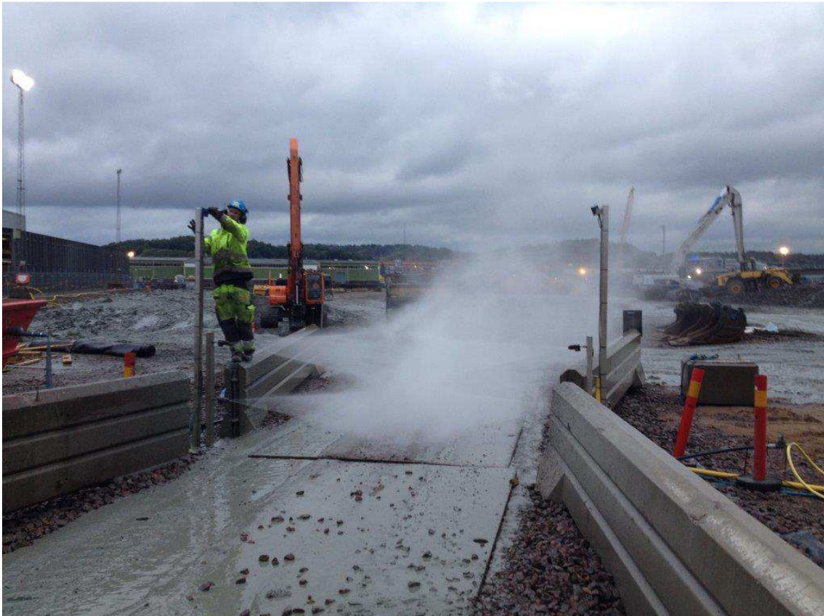
Bild 18. Zublins egentillverkade hjultvätt.
