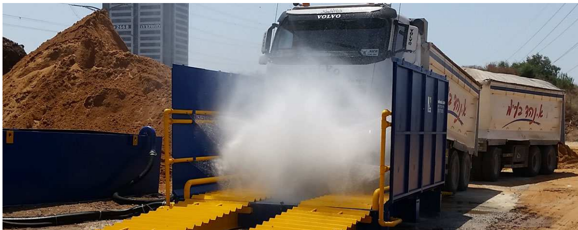
Bild 10. Ett exempel på en hjultvätt som tvättar med lägre volym vatten vid lite högre tryck (Wheelwash, 2016).
