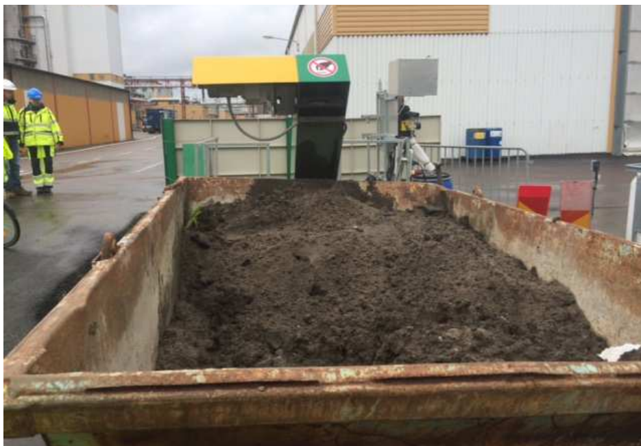
Bild 16. När slamcontainern fyllts transporteras slammet till godkänd mottagare.
