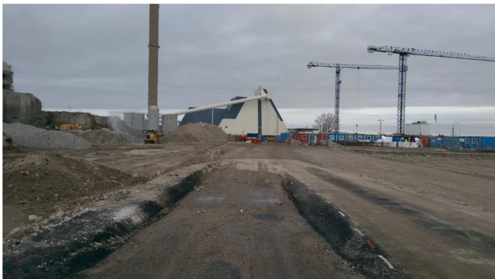
Bild 17. Bassäng vid sanering av Limhamns läge Etapp 2 under konstruktion. I nedsänkningen till vänster i bild sker uttransport från området, och i höger till bild sker intransport till området.
