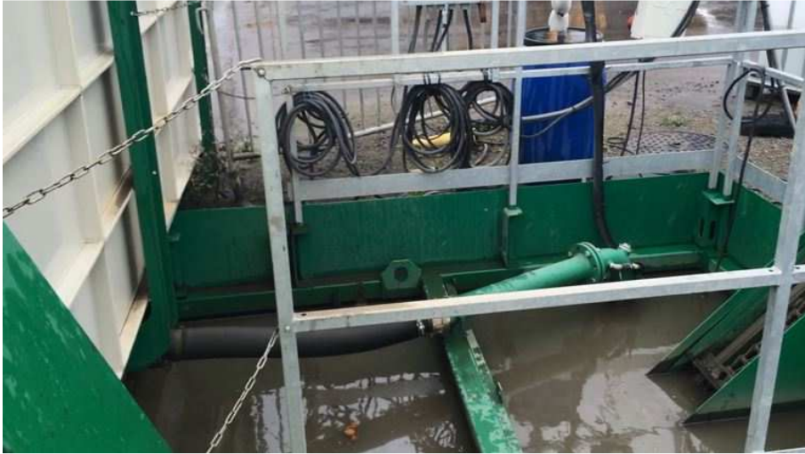
Bild 14. På Akzo Nobel har vattencontainern grävts ner under själva hjultvätten.
