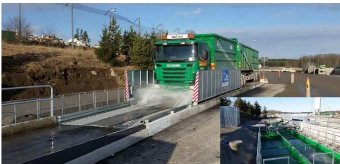
Bild 19. Hjultvätt på Ragn-sells kretsloppsanläggning i Högbytorp, Upplands-Bro (Keston, 2016)
